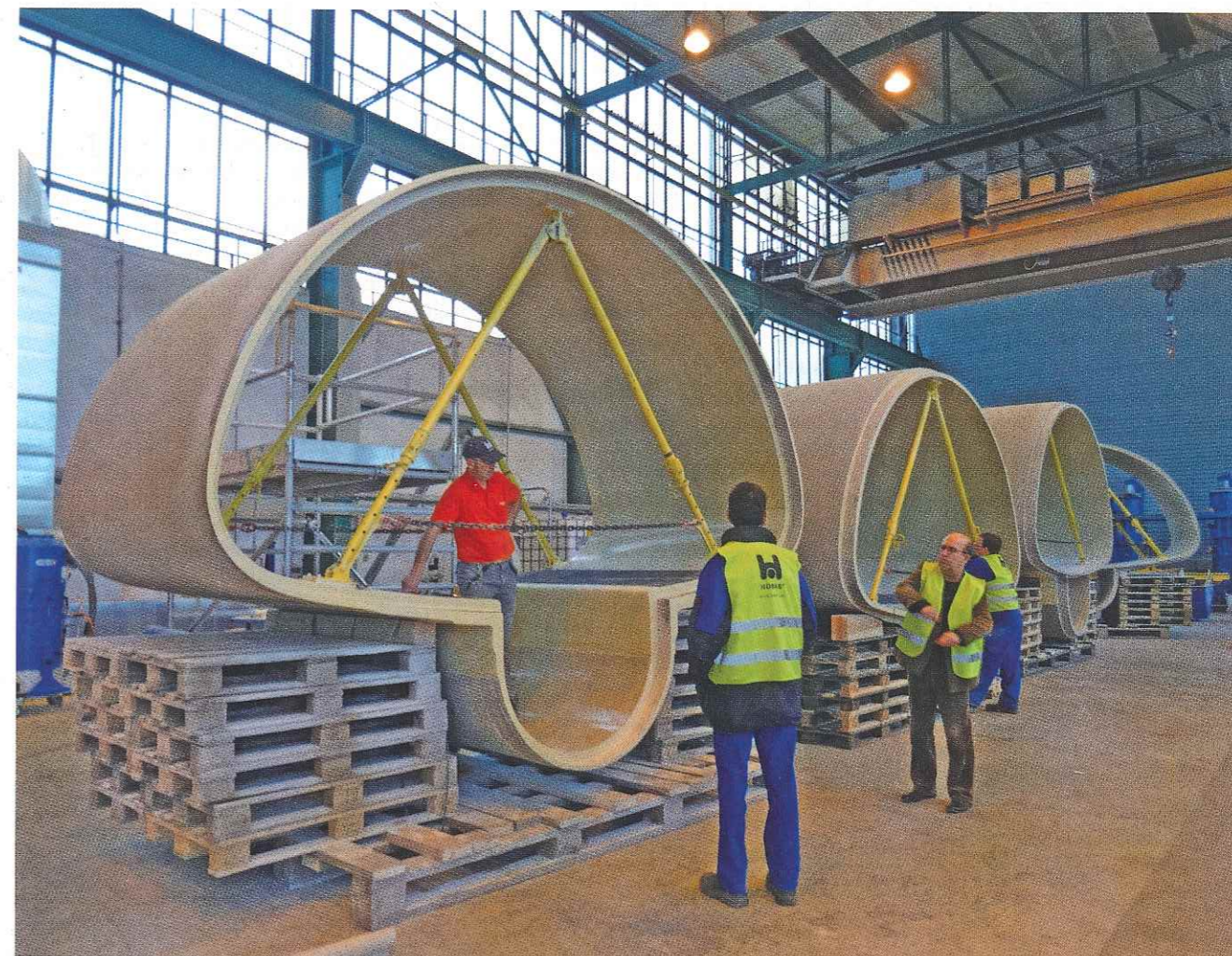
Rohrfertigung im Werk
