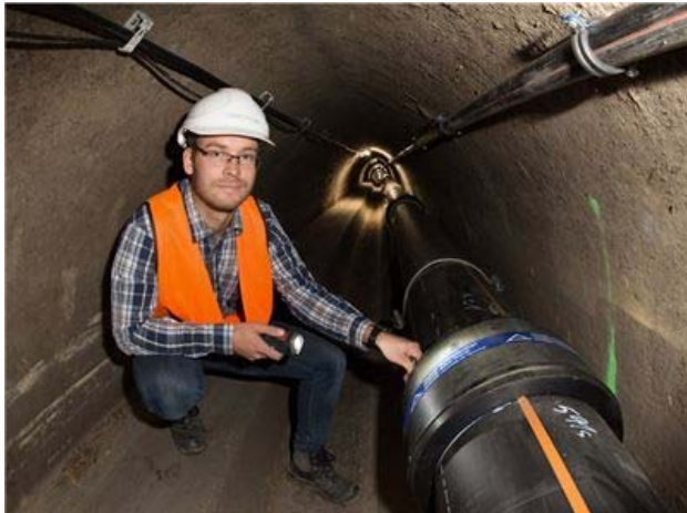
Bauüberwacher Frank Knauth an der neuen Leitung von Wilsdruff, die zum Abwassertunnel unter der Elbe nach Kaditz führt.
